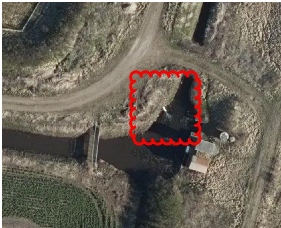
Figur 3-5 Udløb fra Harboøre Renseanlæg til Hovedkanal III
